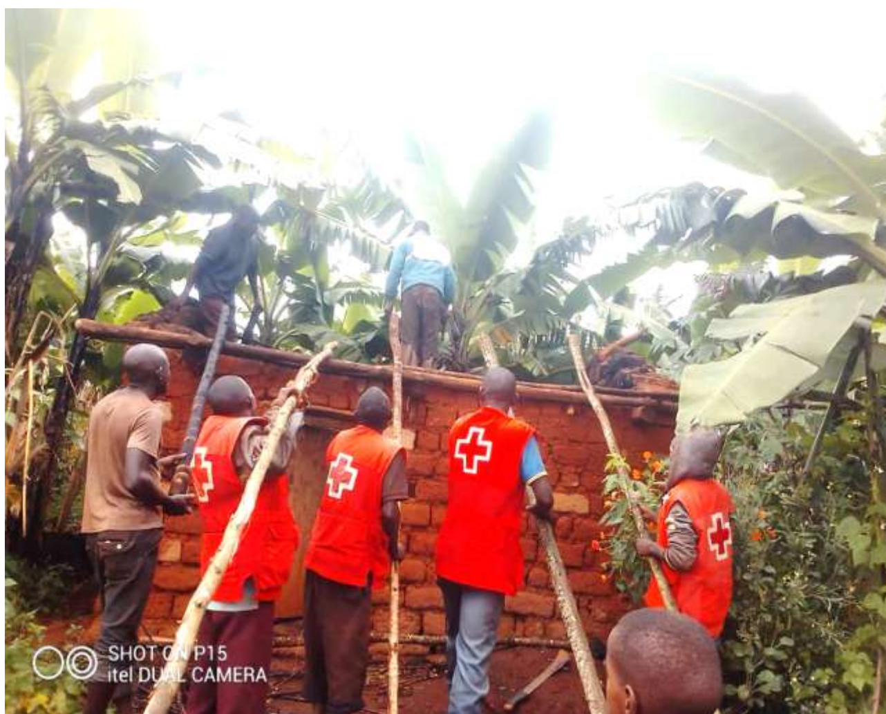
Réhabilitation des abris à Makamba (avec les moyens mobilisés localement)
