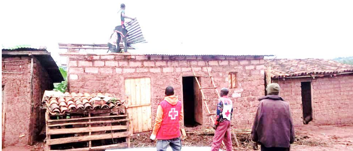
Construction de maisons d'un ménage vulnérables de l'UC Rukungere et ceux de l'UC Kijumbura de la commune Giteranyi, Branche Muyinga
