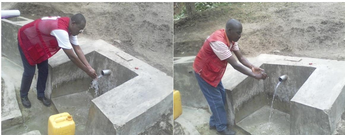
Aménagement d'une source d'eau
