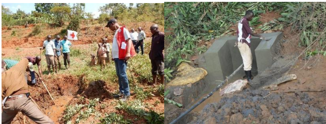
Adduction d'eau réhabilitée par les volontaires
